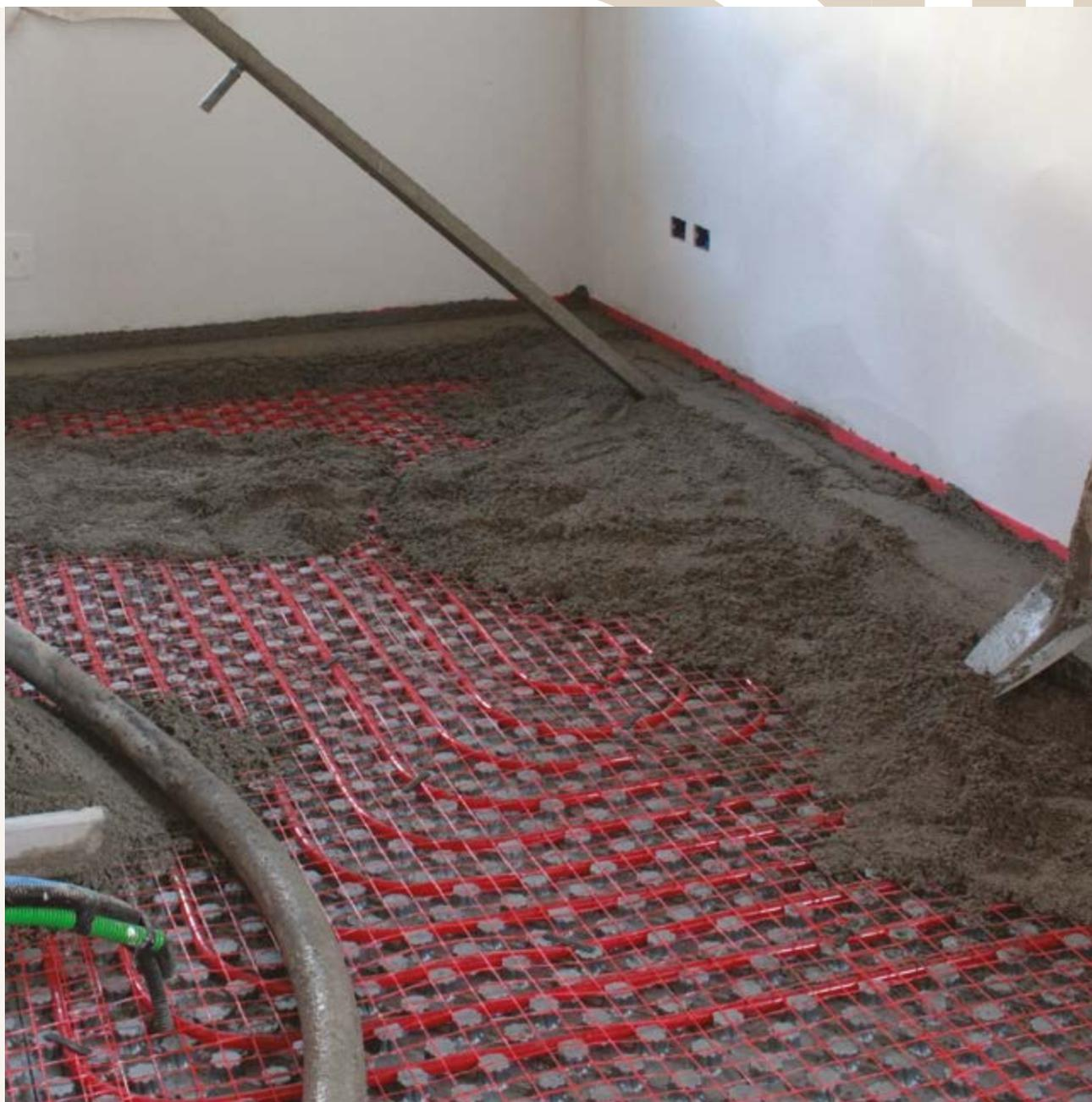
Outre les solutions autonivelantes, FASSA BORTOLO offre une gamme complète de chapes : de celle à prise normale (SC 420 P) aux produits à séchage moyen et rapide (SV 472 P - SR 450). Ces derniers, en particulier, réduisent énormément les délais d'attente pour la pose du revêtement, en atteignant en quelques jours une humidité inférieure à 2 % ; c'est pour cette raison qu'ils sont particulièrement appropriés pour l'application de matériaux sensibles à l'humidité.
